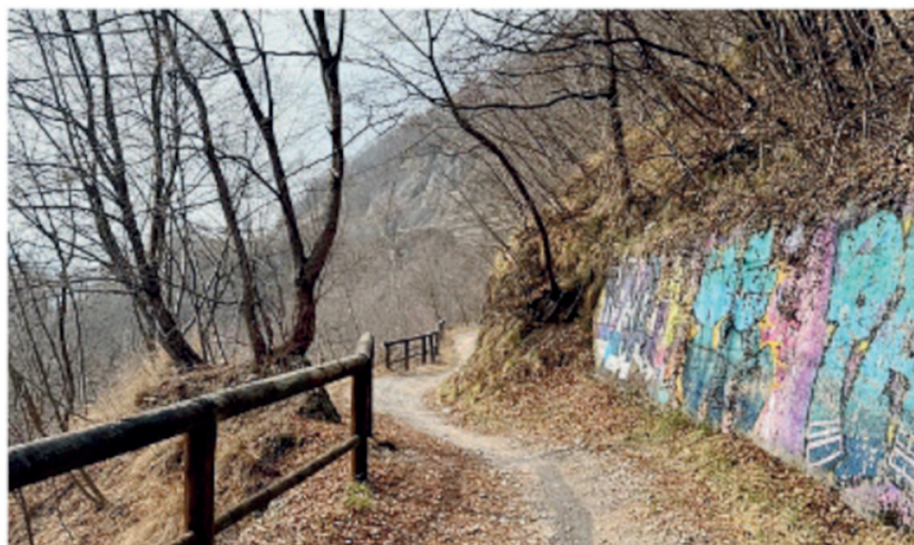
Messa in sicurezza. La strada rurale
