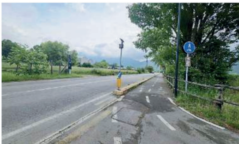
In via Edison. Il tratto di ciclopeditonale sarà messo in sicurezza
