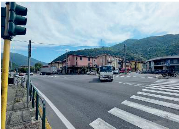
Dove. Qui saranno create due rotonde per eliminare le code
